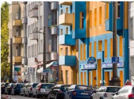
Façades peintes sur les bâtiments (© KWB/ Andreas [FranzXaver] Süß)
