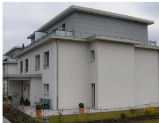
Avancée de toit comme protection contre les intempéries (© OST)
