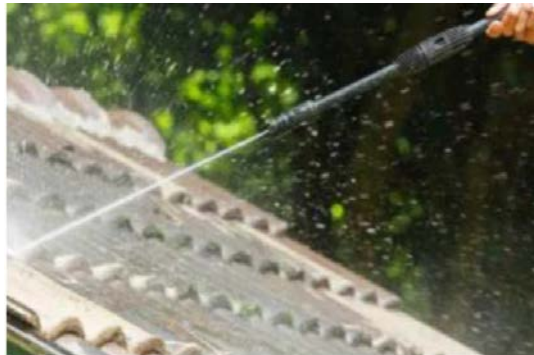
Nettoyage mécanique des tuiles (© OST)
