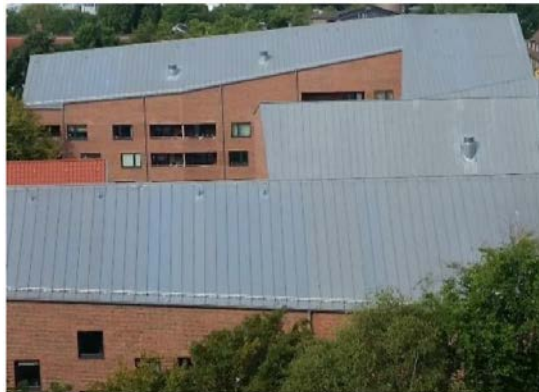
Toit métallique de grande surface en tôle de zinc (© OST)
