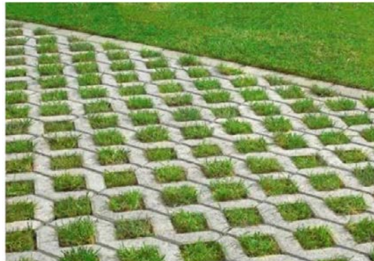
Dalles à gazon alvéolées comme surface de parking (© KWB)
