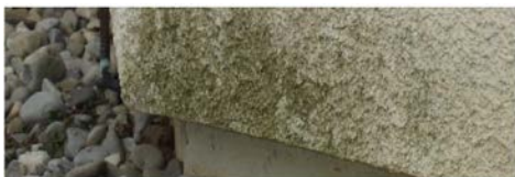
Algues et champignons sur une façade de maison Photo :© H. Bartholemy/ Bundesverband Farbe Gestaltung Bautenschutz
