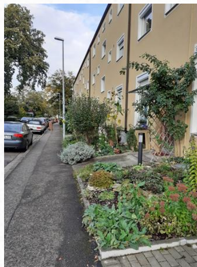
Gärtnerisch genutzte Bereiche am Fuß der Fassaden am Luckenbachweg
