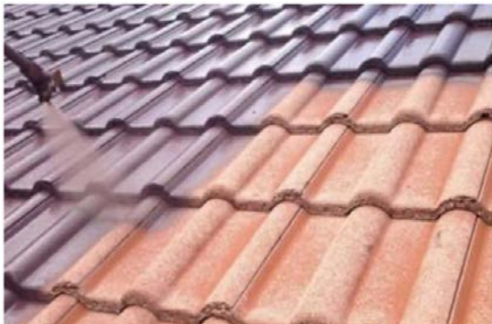
Revêtement des tuiles en cas d'assainissement (© KWB)
