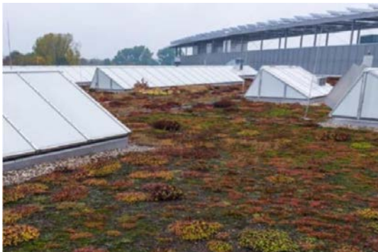
Végétalisation extensive (© KWB [FranzXaver] Süß)
