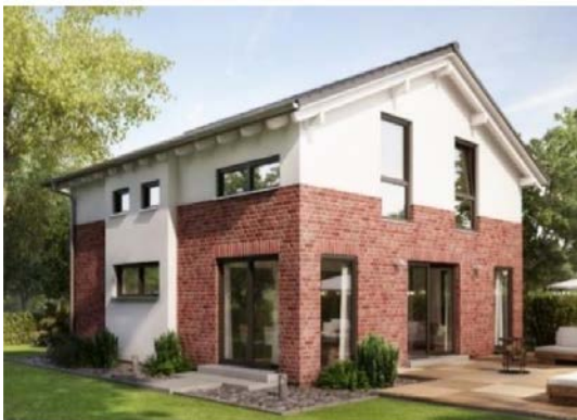
Briques clinker sur les façades (© KWB)
