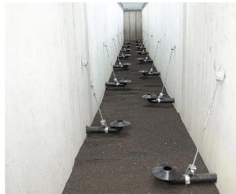
Installation de traitement semi- centralisée (© OST)
